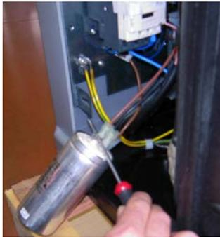
Débrancher tous les câbles retenant la platine à la pompe à chaleur, attention aux crochets qui maintiennent certains connecteurs (emplacement et nombre de connecteurs différents selon modèles, se reporter au schéma électrique présent dans la porte technique ou dans la notice de l'appareil).
