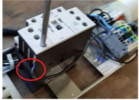
Visser le fil raccordé à la borne L du bornier d'alimentation à la borne 1L1 du contacteur.
