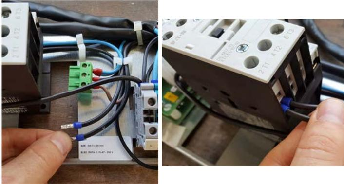
Visser les fils noirs qui étaient raccordés aux bornes R et RC du Smart Starter sur la borne 2T1 du contacteur.
