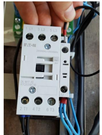
Visser les fils bleus qui étaient sur le connecteur vert, sur la borne A2 du contacteur, et le fil noir qui était sur le connecteur vert, sur la borne A1 du contacteur.
