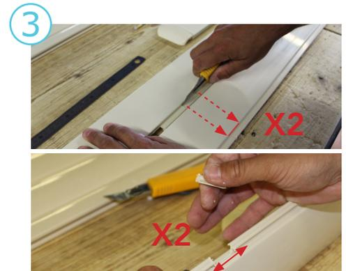
A l'aide d'un cutter, retirer les 2 morceaux de harpon.
