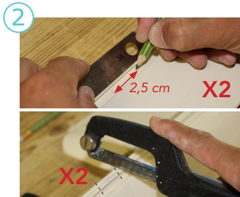
A l'aide d'une scie, faire une entaille de 2,5 cm au niveau du repère sur les 2 lames (respecter l'alignement lors de l'entaille, voir photo suivante)
